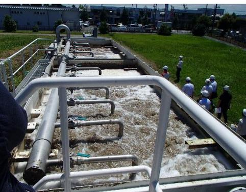
丸い担体が多数投入され、汚れを付着させる汚水槽
