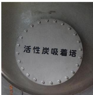
微生物の働きにより、分解が進み、臭いを無くす行程の後、活性炭の脱臭装置により完全に臭いがなくなる。
