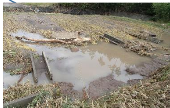
泥流で壊れた用水路と泥をかぶった収穫前の田
