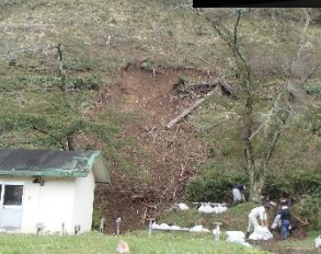
用水路にたまった土砂を取り除き、懸命の復旧活動をする建設課の職員のみなさん。(温井配水池)
