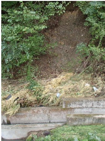
山が崩れ、土砂とともに雨水が運んだ稲束が側溝に堆積。
