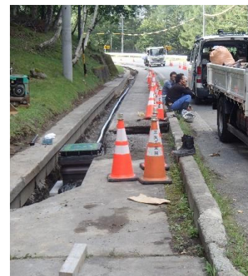
歩道のパイプ埋設工事が始まっている現場。民間会社の夫んで行われている。
