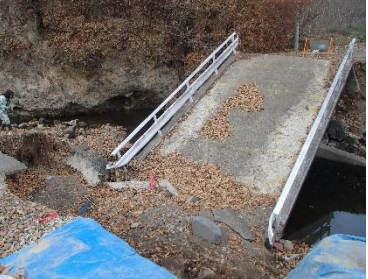
擁壁が流され、落下した梨の木橋(桐原)
