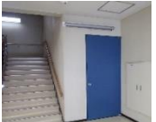
エレベーター室として空間がある。
